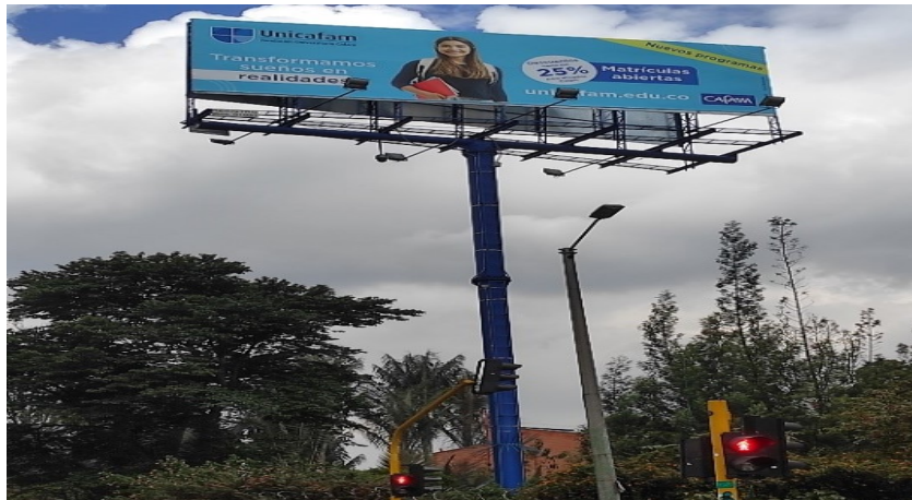
Foto No. 2 – Vista y detalles del panel y de la estructura de la valla, en buenas condiciones y estable, ubicada en la Av. Carrera 68 No. 64 - 45 (dirección catastral) orientación Norte – Sur.
